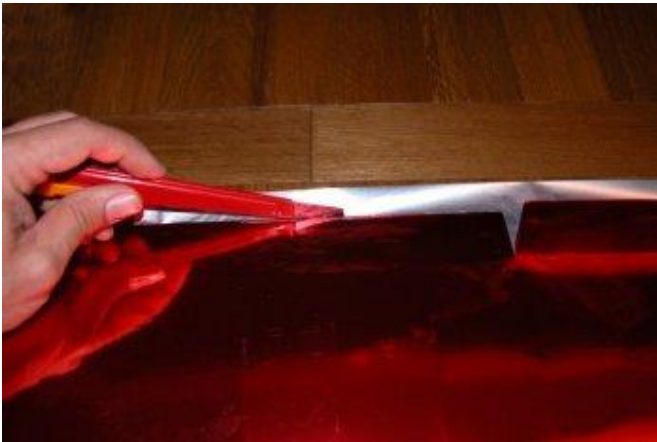
Pour ne pas voir le raccord, le film est arasé sur la tranche avec une lame très coupante.
